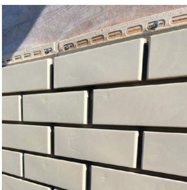
Монтаж без обрешетки.
