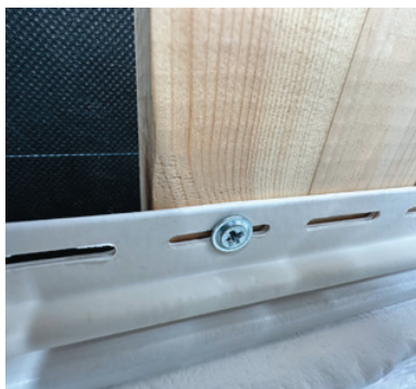
Саморез перетянут, панель неподвижна
