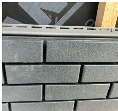
Панель закреплена в распор, неподвижна
