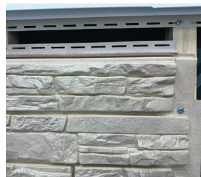
Саморез вкручен в тело панели, панель неподвижна
